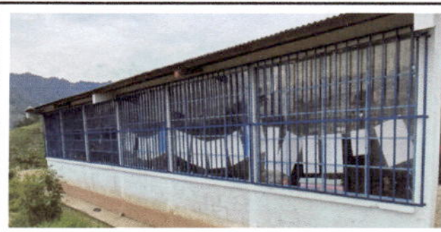
Foto 4: Instalación de balcones de metal
