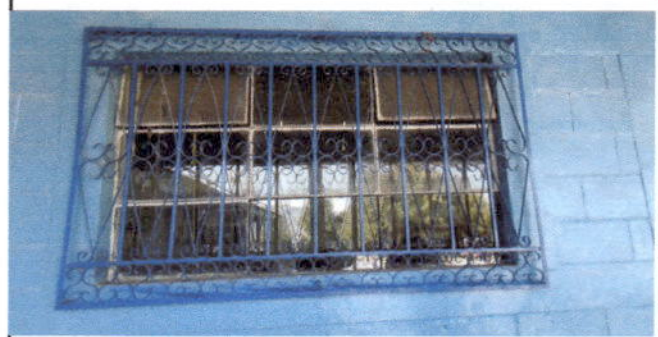
Foto 2: Sustrucción de vidrios
