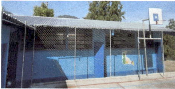
Foto 1: Sustrucción de lámina canalada por lámina troquelada
