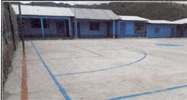
Foto 6: Sustrucción de 80 metros cuadrados de piso en la cancha
